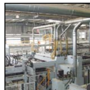
Installation de découpe
